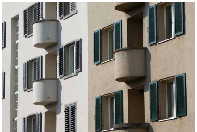
Im Zeichen der Moderne: Bei der dritten Etappe der Siedlung Schöntal griff Architekt Lebrecht Völki ab 1930 auf die Formensprache des Neuen Bauens zurück. (Bild: Peter Niederhäuser, 2017)
